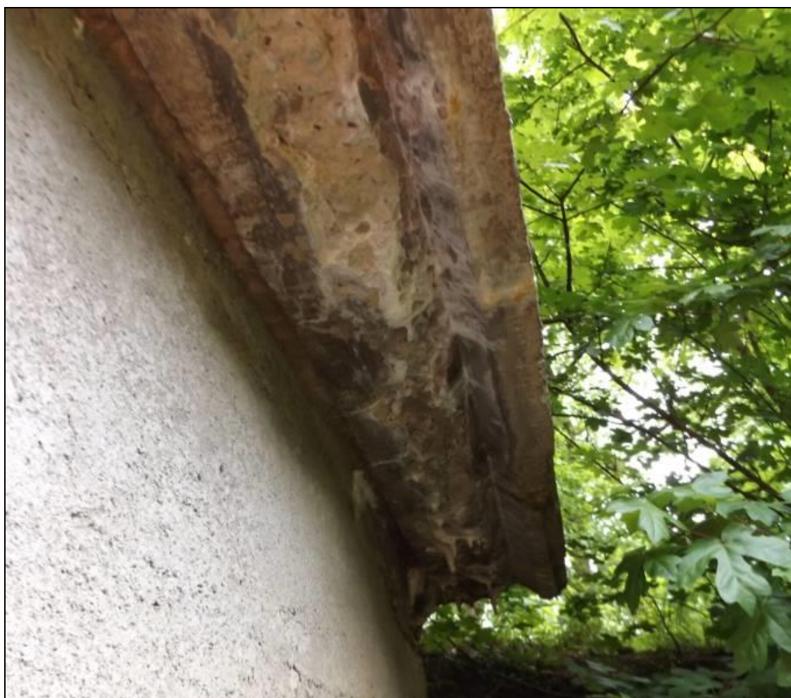
Obr. č. 28 – pohled zespod na římsu závěrné zdi, beton degradovaný vlivem povětrnostních změn
