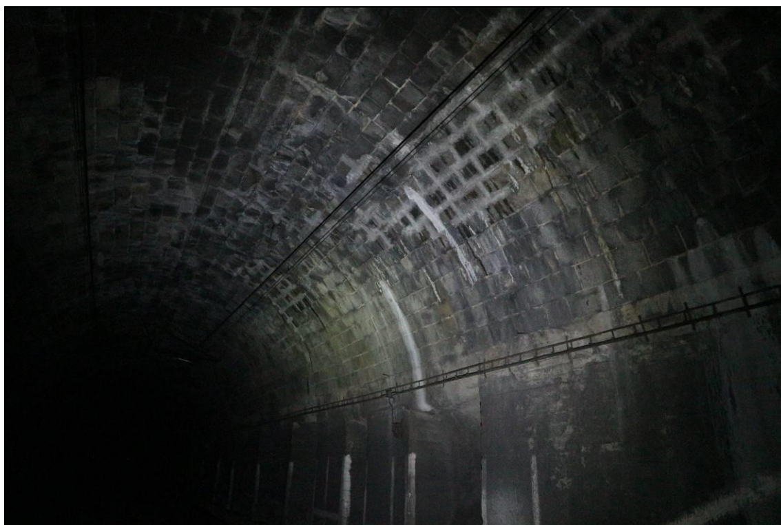
Obr. č. 41 – pohled na přespárované zdivo vpravo nad kolejí č.2 v TP 43-47 - mokré průsaky skrze spáry zdiva
