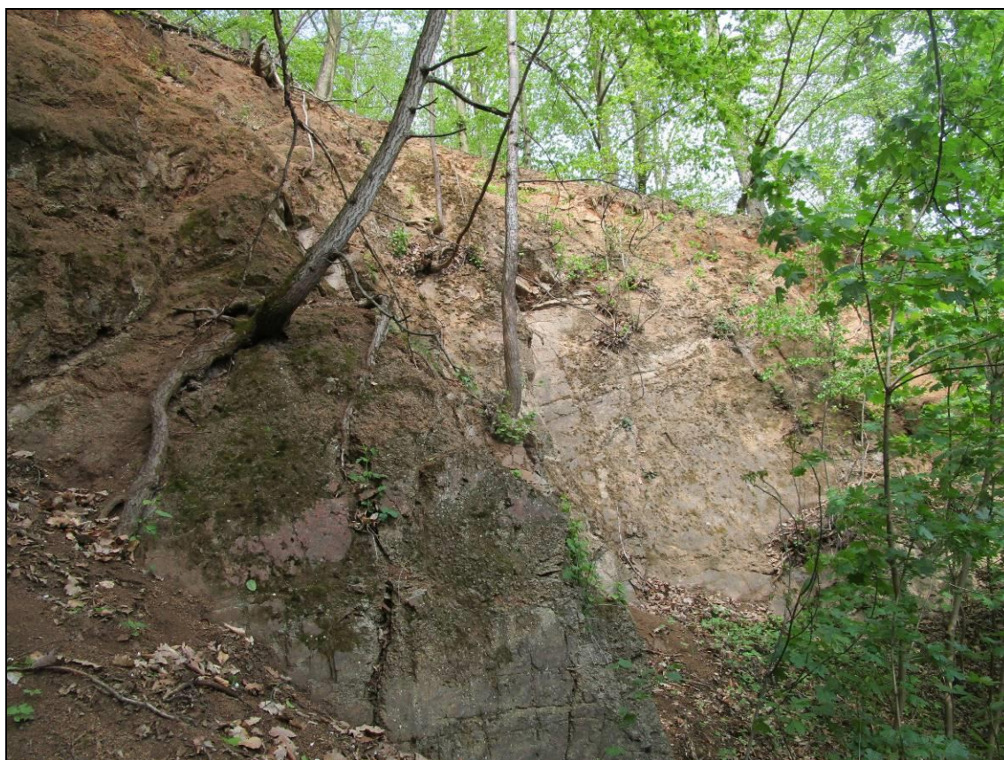
obr. č. 22 Skalní stěna za vjezdovým portálem tvořená granodioritem mírně zvětralým v horní části a na puklinách silně zvětralým až zcela zvětralým
