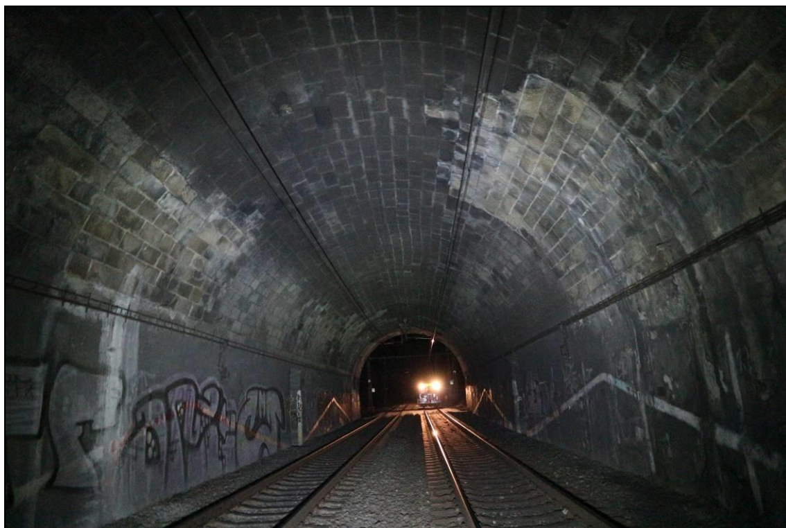
Obr. č. 38 – pohled ke vjezdovému portálu od TP14 - ostění suché, vpravo na foto relikty dlouhodobých průsaků skrze dilatační spáry a spárování klenby TP 11 a 12
