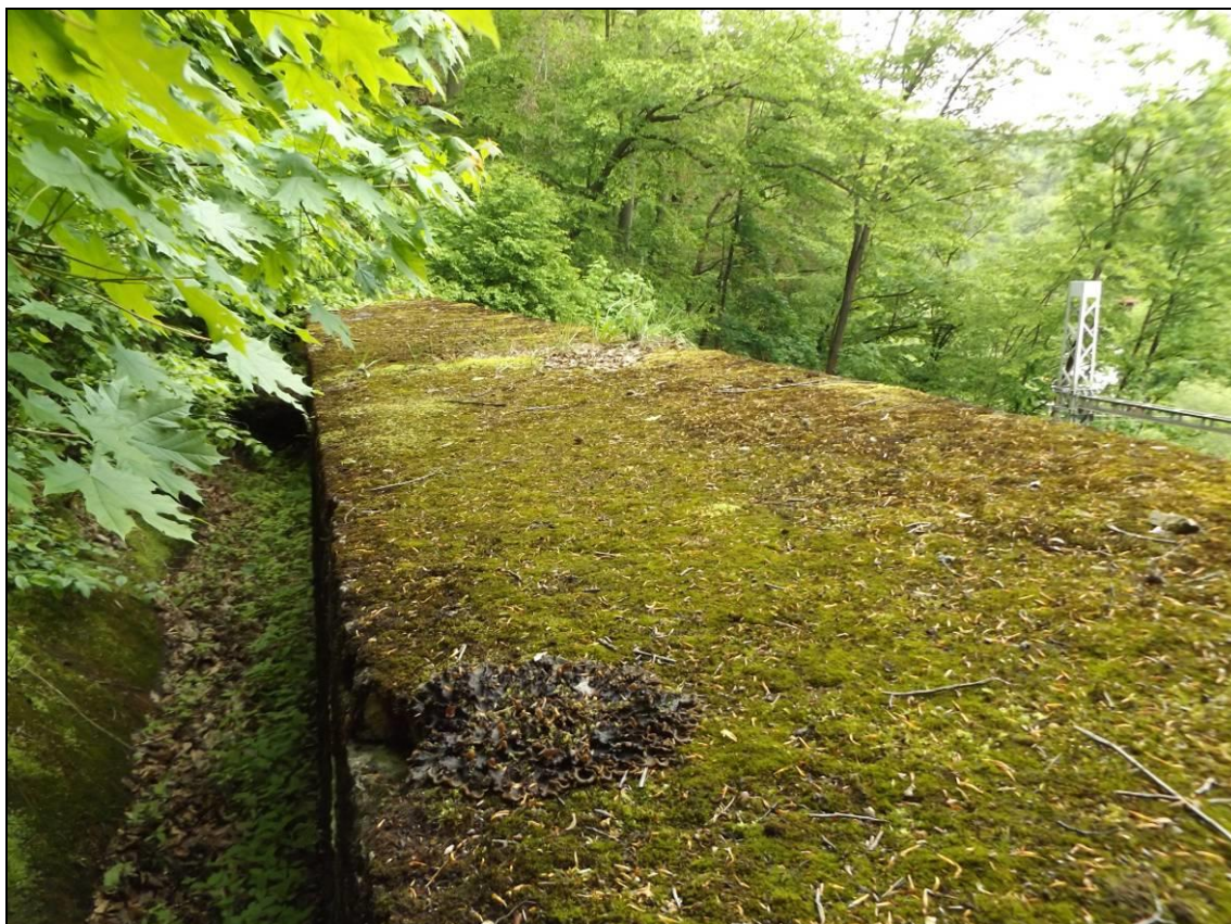
Obr. č. 45 – pohled na betonovou římsu zídky, vlevo odvodňovací žlab zanesený organickým materiálem
