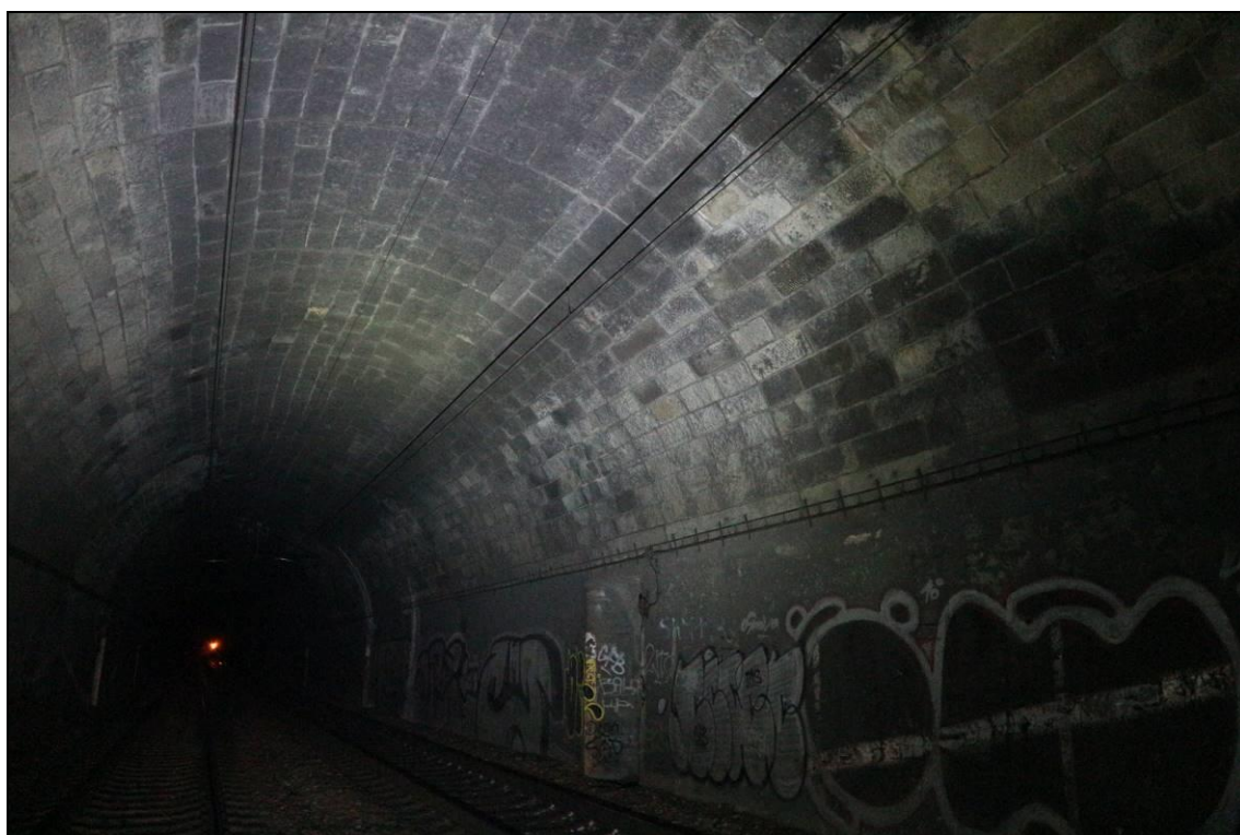
Obr. č. 37 – pohled na vnitřní líc ostění TP 4-11 - ostění suché, téměř bez známek průsaku
