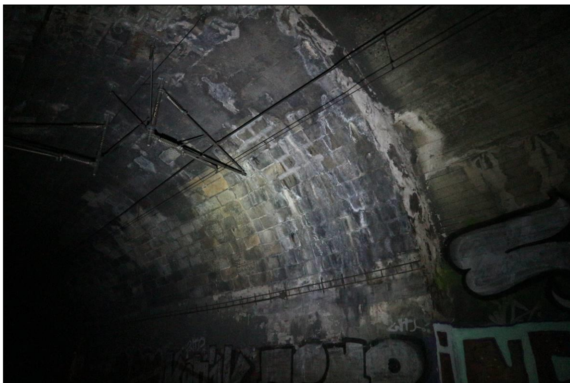
Obr. č. 35 – pohled na vnitřní líc ostění TP 3, vpravo nad kolejí č. 2 - středně silné průsaky skrze spárování zdiva, které je silně degradované a lokálně vypadané
