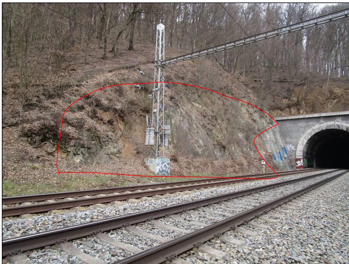
obr. č. 19 Skalní svah odřezu v předportálové části vjezdového portálu km cca 167,572-167,612, červenou čarou je označena část skalní stěny, kterou bude vhodné zakrýt ochrannou sítí
