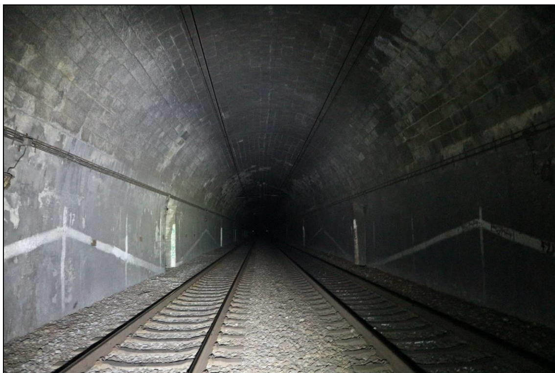
Obr. č. 39 – pohled na vnitřní líc ostění TP 17-23 - ostění suché, téměř bez známek průsaků, ojediněle relikty velmi slabých bodových průsaků
