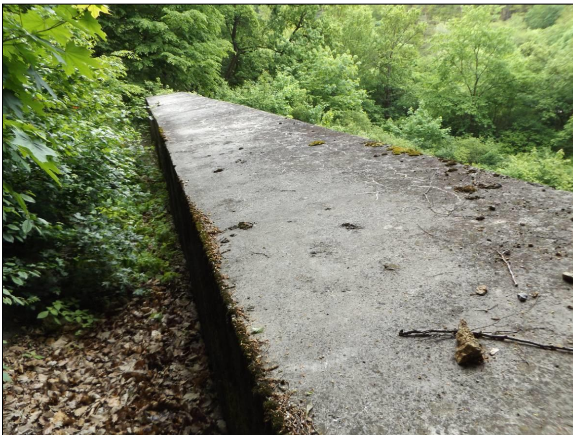
Obr. č. 33 – pohled shora na betonovou desku římsy závěrné zídky portálu P/1
