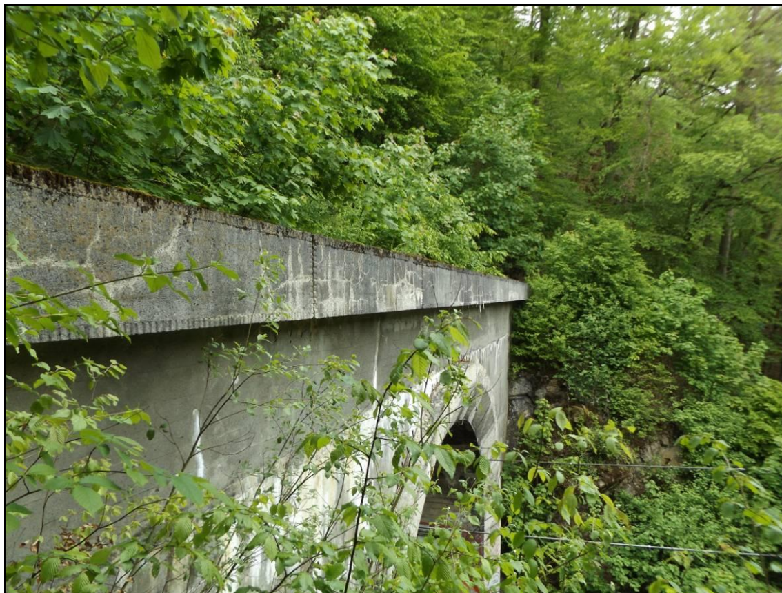
Obr. č. 46 – pohled na římsu závěrné zdi v čele s vlasovými trhlinami, dále viditelné průsaky na styku čela portálu a závěrné zdi
