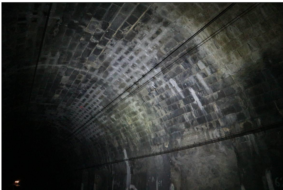
Obr. č. 43 – pohled na přespárované zdivo klenby, vlevo nad kolejí č. 1, lokálně bodové mokré průsaky
