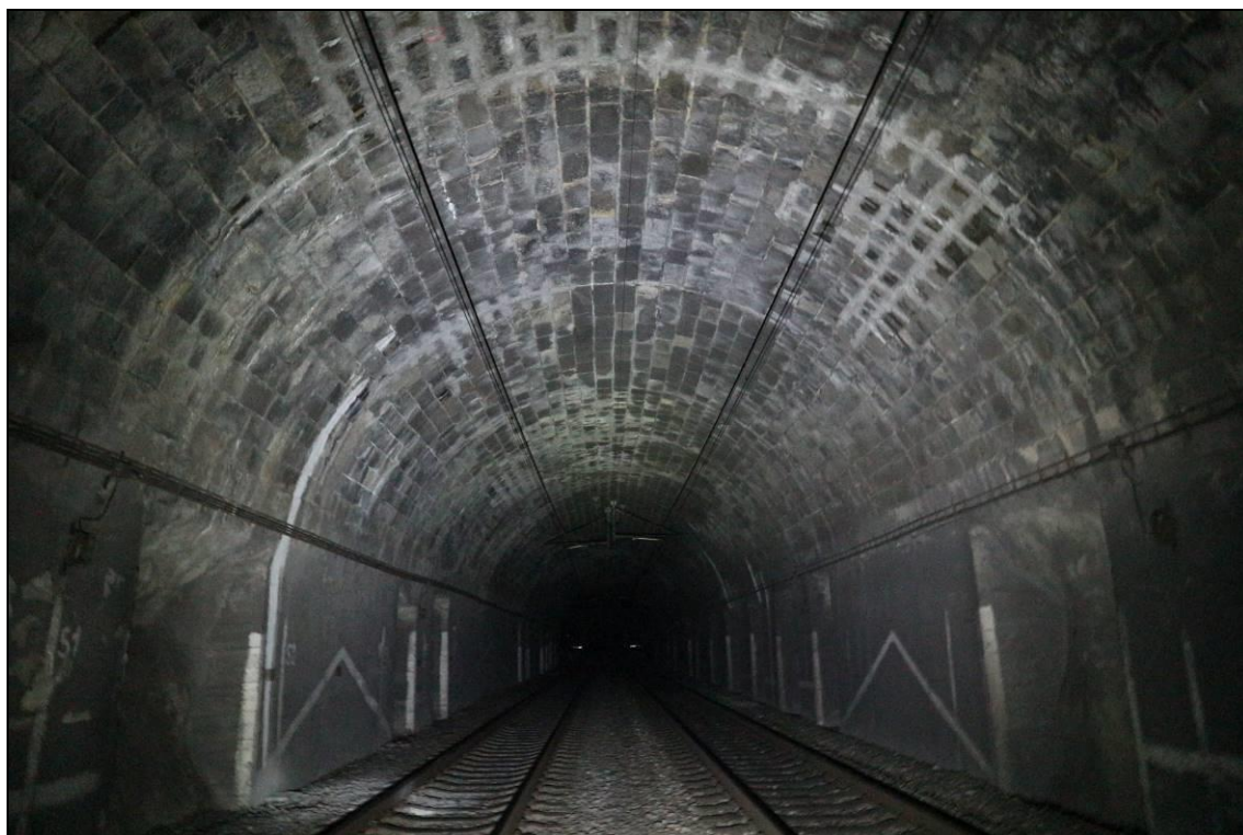
Obr. č. 42 – pohled k výjezdovému portálu od TP 51, spárování klenby je lokálně vyspraveno, i přes to v něm dochází k mokrým průsakům, v lici známky po dlouhodobých plošných průsacích skrze spárování
