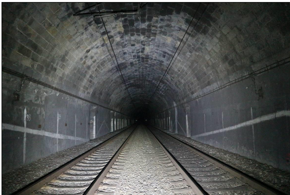
Obr. č. 40 – pohled k výjezdovému portálu od TP 38 - ostění suché, v líci klenby se vyskytují relikty slabých dlouhodobých průsaků skrze spárování zdiva
